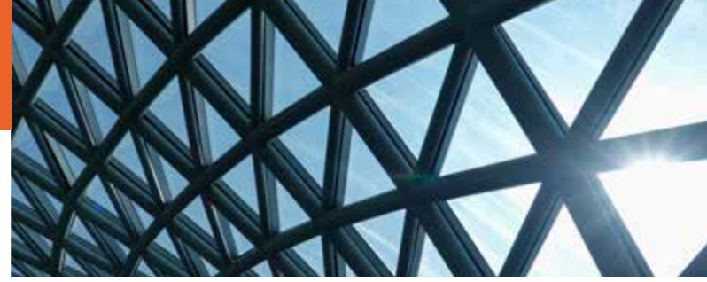
Yapı ve İnşaat
